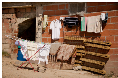
Uno dei tanti edifici abbandonati di Boush Bouk, quartiere di Algeri (Algeria), in cui vivono immigrati indigenti (Andrew Galea Debono/JRS Europe)
